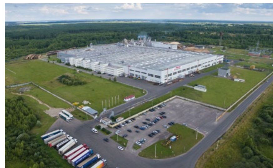
Завод в Шuye Plant Shuya
