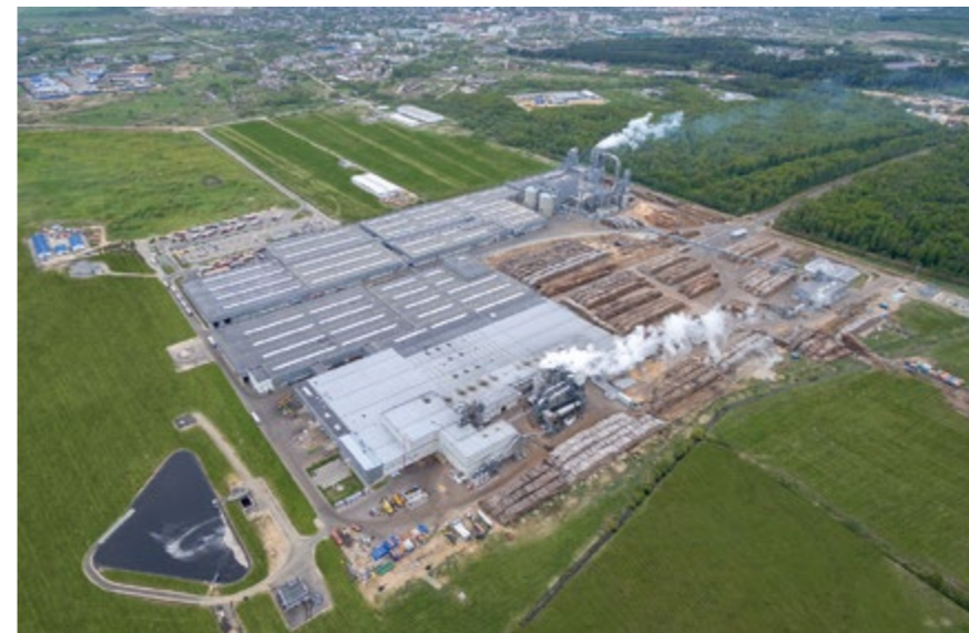
Завод в Гагарине Plant Gagarin
